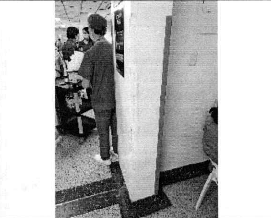
Fotografía 14. Muro y esquinero pvc servicio de Urgencias en mal estado.
