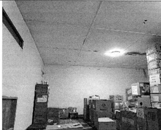
Fotografía 10. Cielo raso de Almacén General en mal estado.
