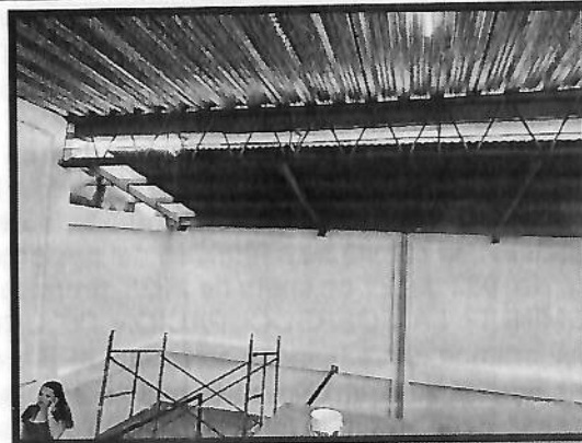
Fotografía 2. Cubierta metálica sin cielo raso alguno.
